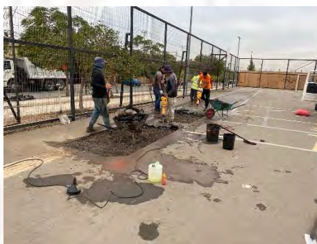
Trabajo de demarcación de carpeta asfáltica Los trabajos comienzan por retirar pavimento en mal estado y su reemplazo
