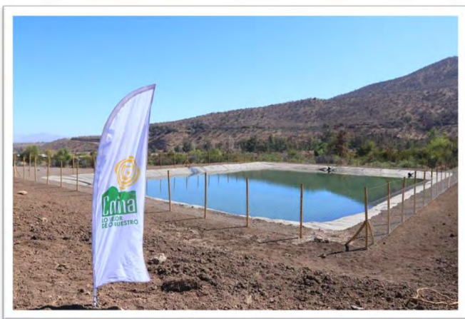
Construcción de Obras para la Comuna
