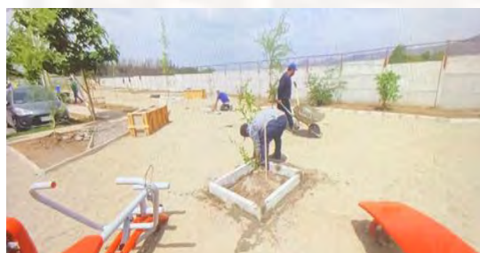
Ejecución del proyecto
