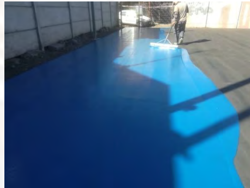
Mejoramiento base, confinamiento solerillas perimetrales, asfalto y sellos. Imprimación primera capa pintura acrílica.
