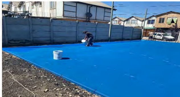
Aplicación segunda capa de pintura acrílica.
