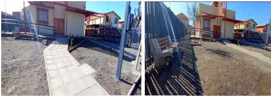
Ejecución del proyecto
