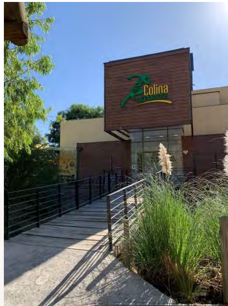
Entrada principal Gimnasio Funcional Chamisero, 2023
