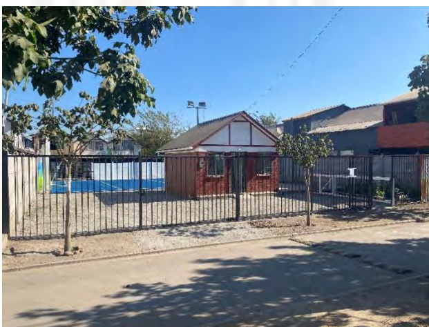
Se ejecutó un nuevo cierre y se reforzaron los fondos de arcos con malla a 5 m de altura.
