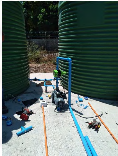
2 estanques de acumulación de agua de 10.000 lt y una red impulsada por bombas permiten un riego óptimo
